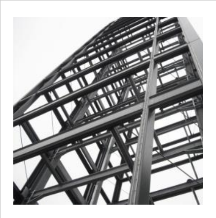
Basisstruktur der Fassade als (Trockenverglasungssystem)
